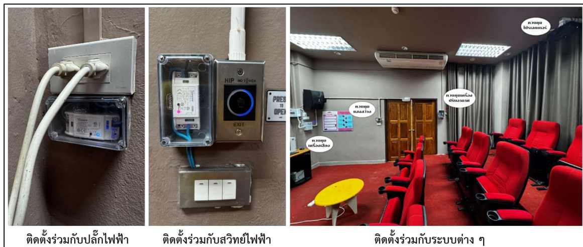
ภาพที่ 5 แสดงการติดตั้งอุปกรณ์ Sonoff กับระบบไฟฟ้าเดิม
